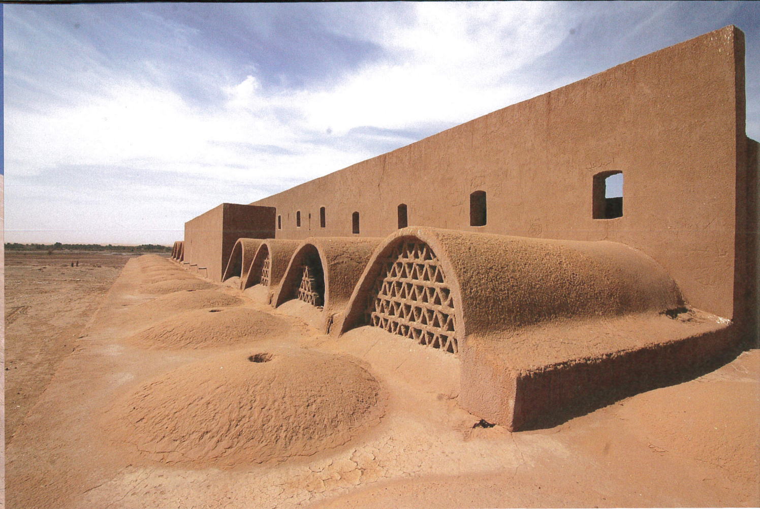
▲ A piac természetes hűtését elősegítő felépítmények (1963–67). Az épület befejezetlen maradt a hatnapos háború miatt. Új-Bárisz, Kharga-oázis
