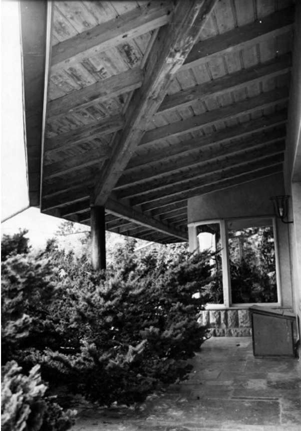
2. Fritz August Breuhaus: Küttel-villa , 1933–1934 délkeleti homlokzat a télikerttel (Fotó: Harrach Erzsébet, 1970-es évek)
