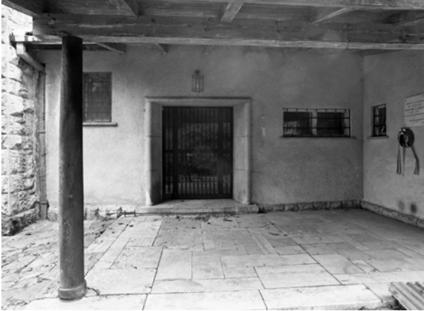
5. Fritz August Breuhaus: Küttel-villa , 1933–1934 bejárati ajtó a terrasszal (Fotó: Galacanu Efstatia, 2000)
