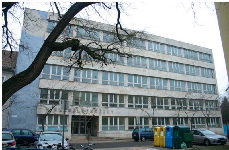
1. ábra. A kiskunfélegyházi volt SZTK-épület utcai homlokzata a felújítás előtt
