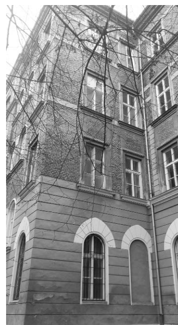
A felújítás előtti udvari homlokzat
