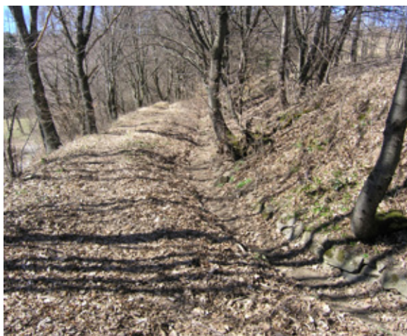
110. Az Irtványosi- felső vízvezető árok
