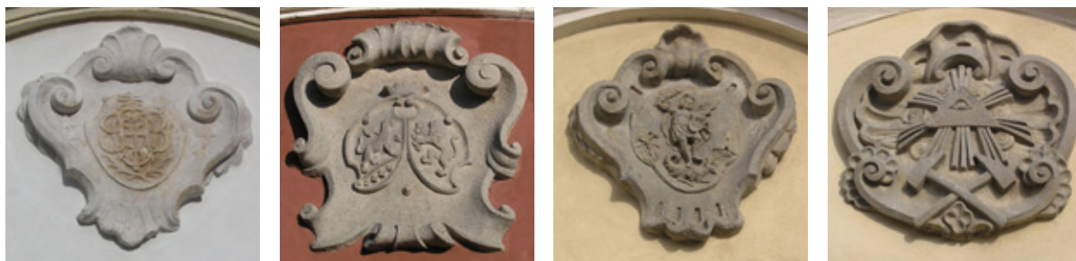
152. Négy, jó állapotban megmaradt címer a kápolnák homlokzatán
