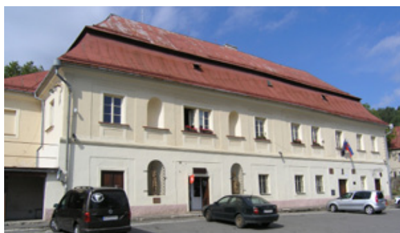
56. A széklaknai kamarai kereskedőház
