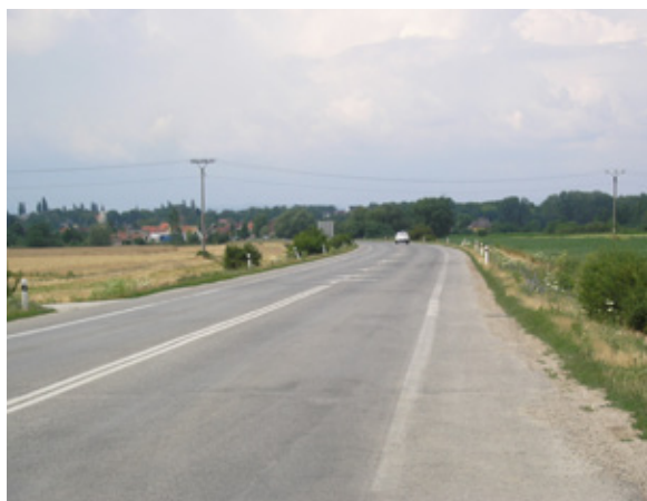
220. A terven S-T jelű szakasz mai képe Karkóc felé, 3,5 láb magas töltésen
