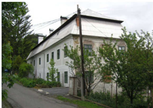
55. A széklaknai volt jezsuita rendház - helyreállítás közbeni állapot 2019-ben
