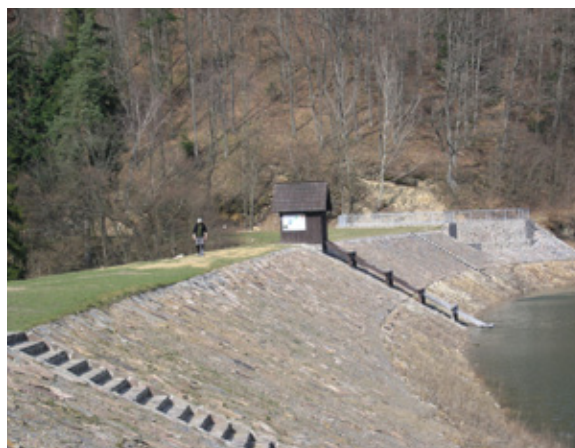
143. A Hodrusi-Alsó-tó gátja a csapházzal és a túlfolyóval
