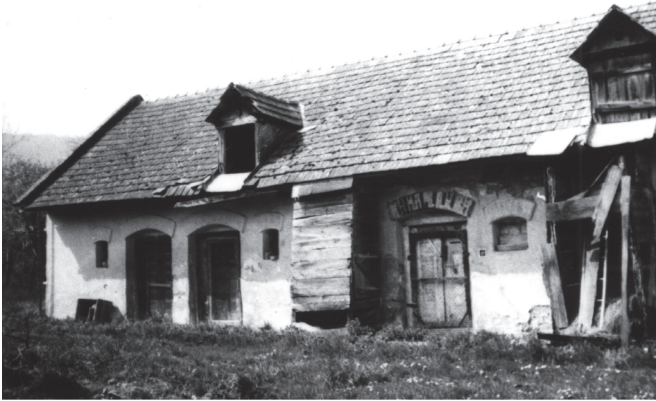
30. kép. Marhaólak padlyukkal és ereszt alatti szénatartóval (egyik már romos). Méhész. Paládi-Kovács A. felv. 1994.
