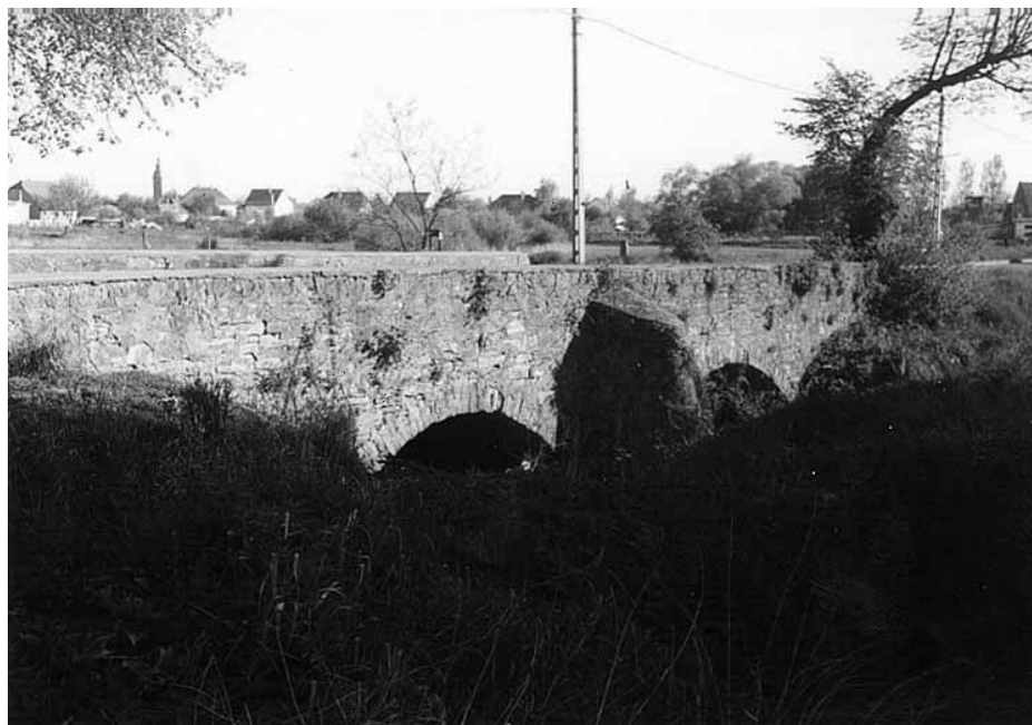
10. ábra. A Sárospatakon lévő, már funkcióját veszített, boltozott kőhíd
