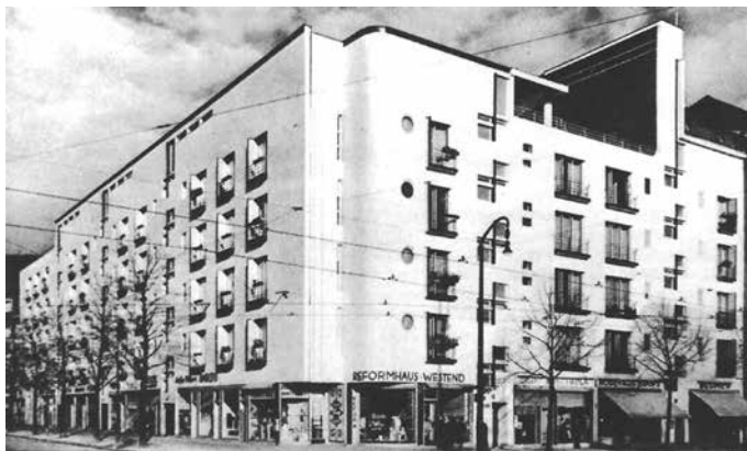
10. ábra. Kaiserdamm társasház, Berlin, 1929
