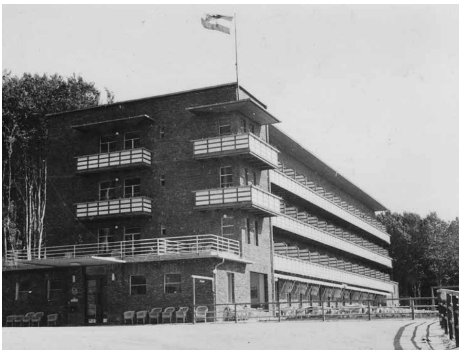
7. ábra. Mátraháza, szanatórium, A épület
