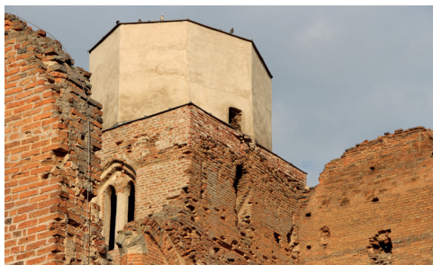
12. A torony a legutóbbi műemlékvédelmi beavatkozásokat követően (2017)
