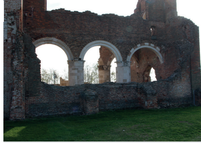
11. A főhajó 1970-es években újjáépített északi fala (2017)
