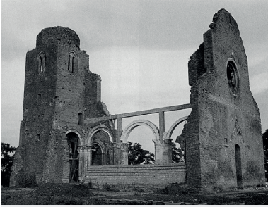
10. Az újjáépülő főhajófal vasbetonbetonváza (1970-es évek)
