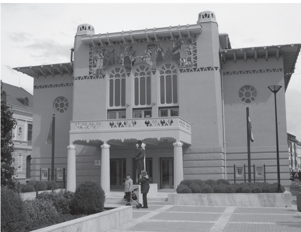
Abb. 22. Sopron (Ödenburg), die wiederhergestellte Hauptfassade des Theaters (Foto: Pál Lövei, 2013)
