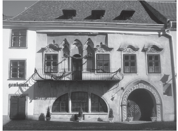
Abb. 6. Sopron, Fő tér 3. (Ödenburg, Hauptplatz 3.), Fassade des Gambrinus-Hauses mit dem Rest der gekoppelten, stufenartig geformten Fenstergruppe (Foto: Pál Lóvei, 2007)
