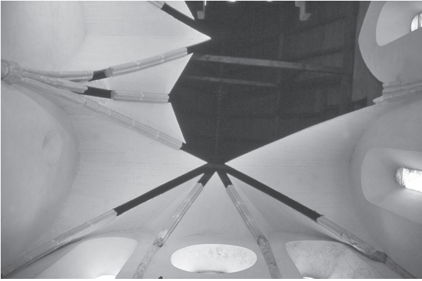
Abb. 5. Sopron (Ödenburg), Gewölberekonstruktion der mittelalterlichen Alten Synagoge (Foto: Pál Lóvei)
