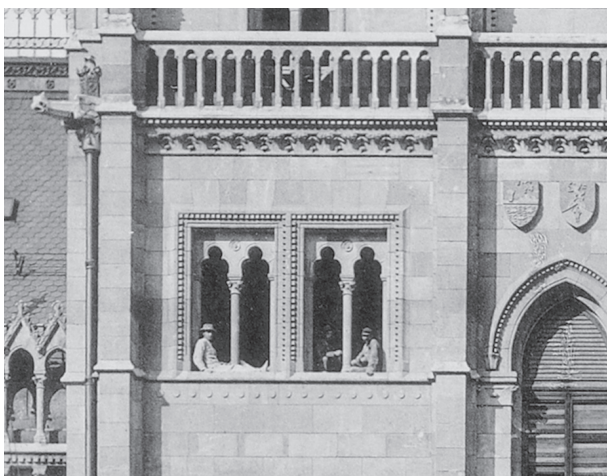
Fig. 30. Ouvriers dans la fenêtre du bâtiment. (Licht, Hugo [Hg.], Architektur der Gegenwart . Band V., Lieferung 20. Berlin. s. d. [1896] 4, détail)
