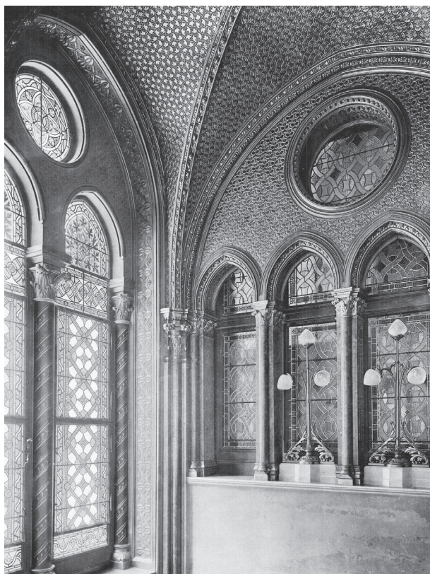
Fig. 61. Une partie de l'un des escaliers de la chambre haute [Photo Károly Divald, in PILISI NEY (op. cit., note 3)]
