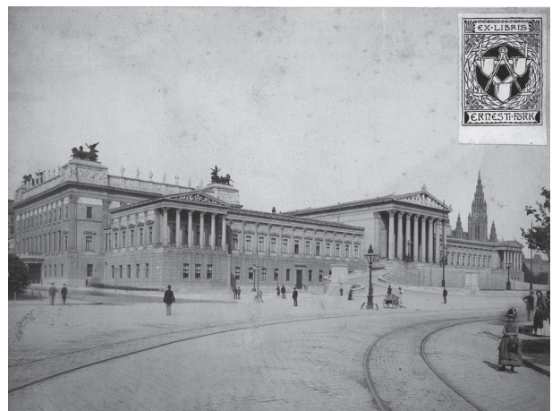
Fig. 16. Vienne, Parlement, photographie provenant du bureau d'Imre Steindl. Musée hongrois de l'architecture, Budapest
