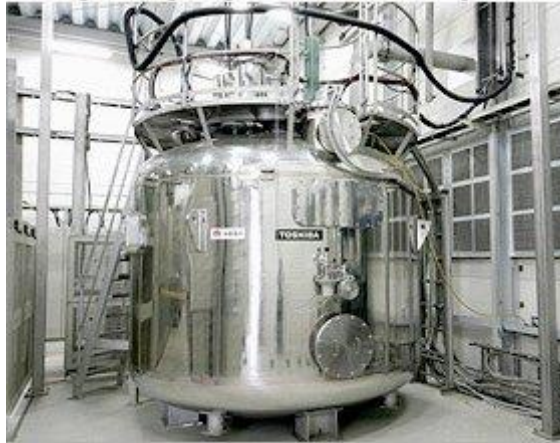
15. ábra A világ legnagyobb SMES-e Japánban Kameyama-ban található, 10MW-os
