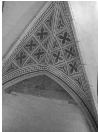
3. kép. Boltozatmező a karzat felett, restaurálás és kiegészítés után. Fotó: Kristína Markušová
