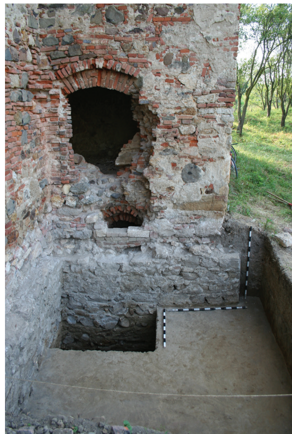
9 – Elevația și fundația bastionului SE (F'), (SI – profil E)
