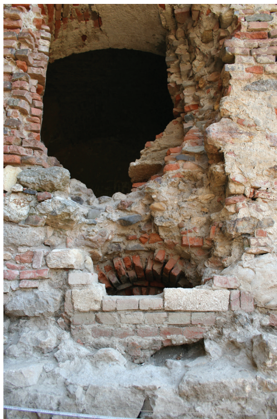
15 – Fereastra bastionului SE și fereastra de pivniță parțial zidită
