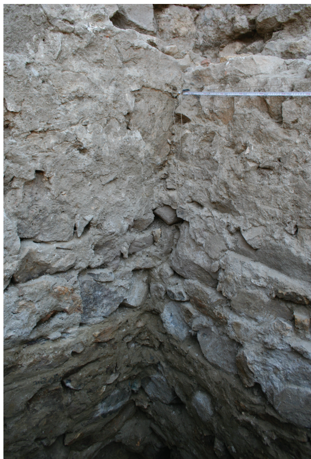
18 – Îmbinarea fațadei principale cu bastionul SE – fundație
