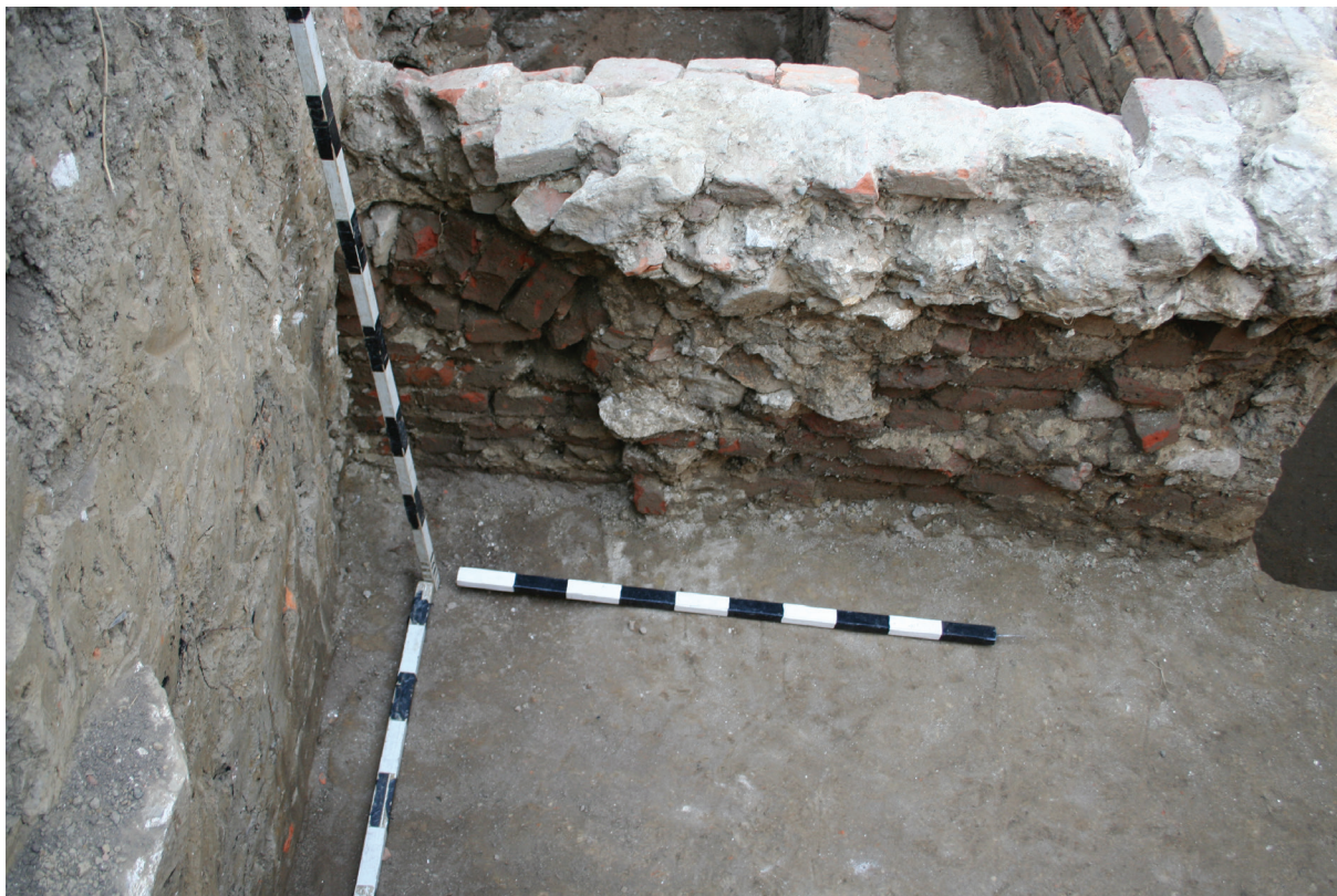
33 – L2, latura V, detaliu de zidărie (exterior)
