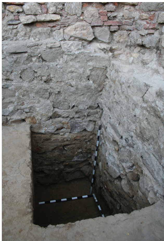
17 – Îmbinarea fațadei principale cu bastionul SE – fundație
