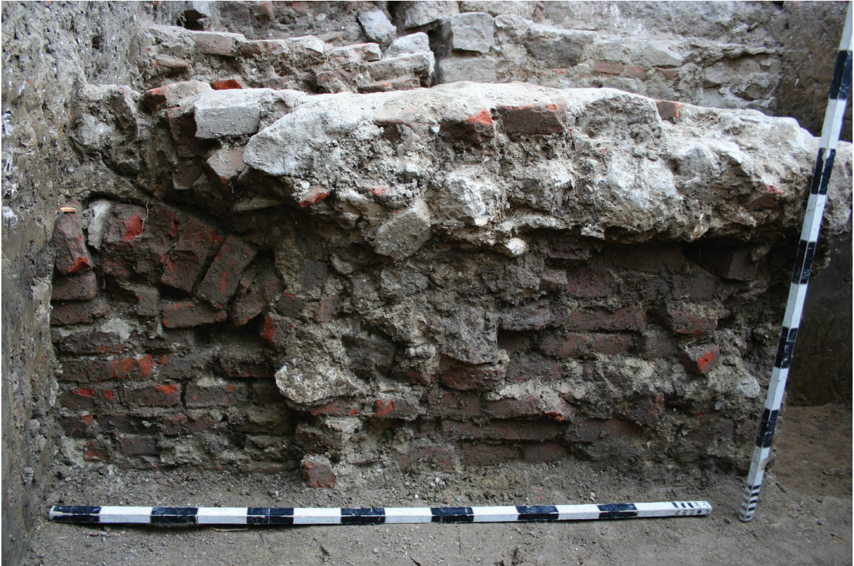
35 – L2, latura V, detaliu de zidărie (exterior)
