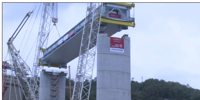
6. ábra: Az épülő új viadukt első darabja
