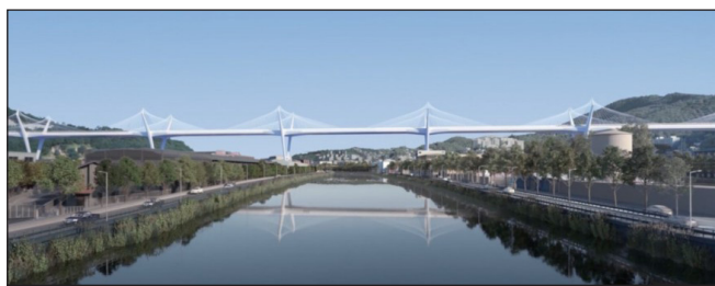
20. ábra: Ponte dei pescatori – Image © Santiago Calatrava
