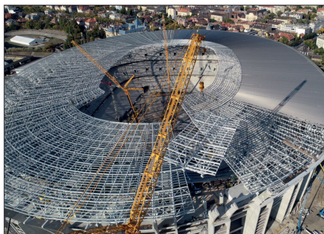
5. ábra: utolsó tetőelem elhelyezése
