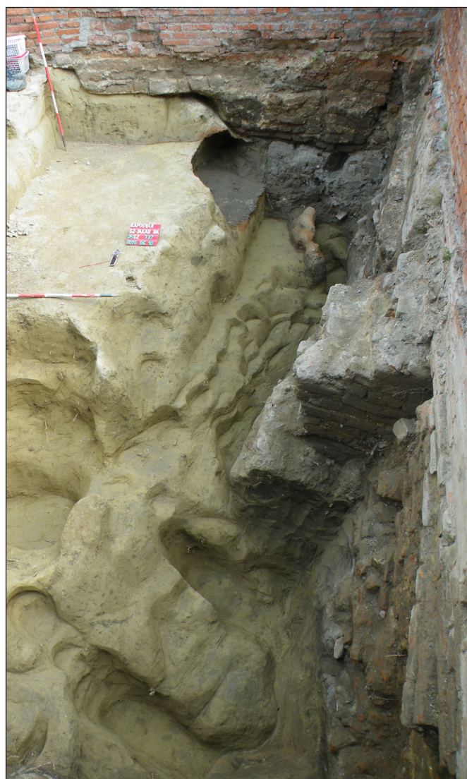
13. kép. A faszerkezet domboldalba való bekötését szolgáló, párosával álló vízszintes gerendasorok nyomai
