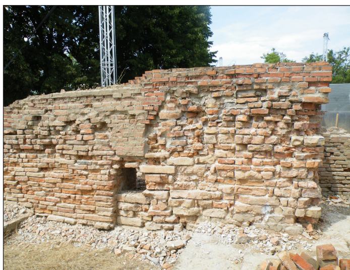
5. kép. A műemléki felújítás során készült képen jól elkülöníthetőek a korai templom felhasznált falszakaszai
