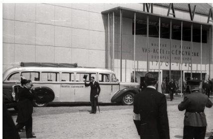
A Magyar Légiforgalmi Rt. (MALERT) részére gyártott autóbusz, MÁVAG LO 4500 Uhri-féle felépítménnyel (1940) (FORTEPAN / Lenkey Márton)
