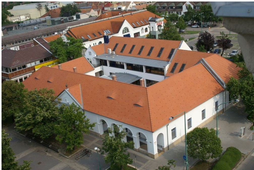
2. ábra: A városi könyvtár régi és felújított épülete
