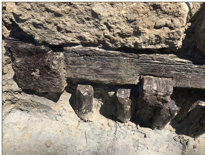
9. kép. Csapolt gerendaszerkezet és cölöpsor részlete hídnylás északi oldalán (fotó: Hajdu Barbara)
