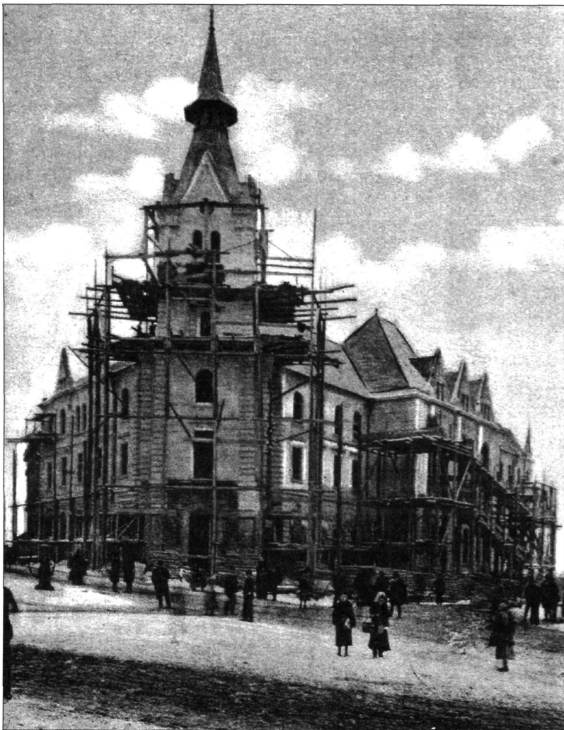
3. ábra. Az épülő kaposvári városháza, 1902
