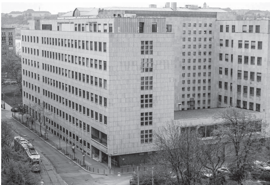
3. Ex ministero dell'interno (oggi Ufficio dei Deputati del Parlamento), 1948 Architetti: Ágoston Benkhard, László Gábor, Lajos Gáboros, Gábor Preisich
