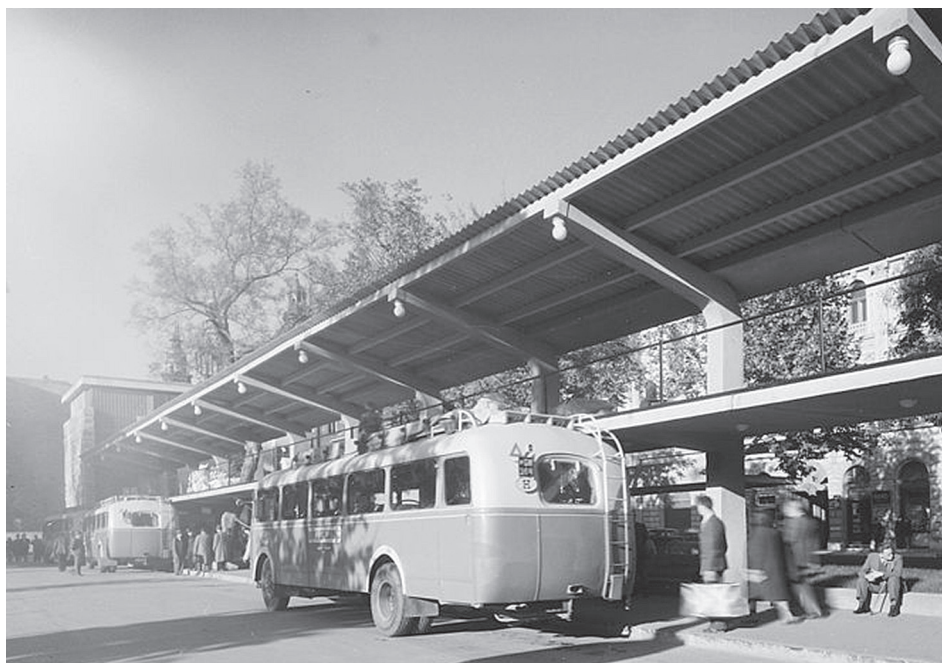
7. Stazione dei pullman (Vedi la foto 6.)
