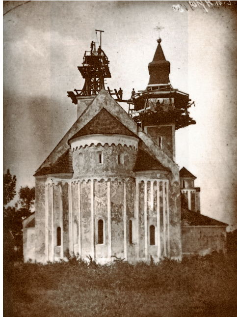
The enlarged church from east. Photo: Péter Gerecze, circa 1900(?), Source: Magyar Építészeti Múzeum és Műemlékvédelmi Dokumentációs Központ, Fotótár, Plate no. 3482.
