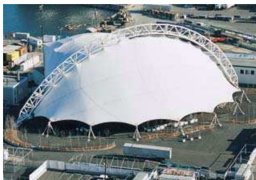
1. ábra: Egy rácsos ívre hagyományos módon, rövid, független kábelekkel feszített ponyvaszerkezet (Bank of Amerika Pavilion, Boston, MA, USA)
