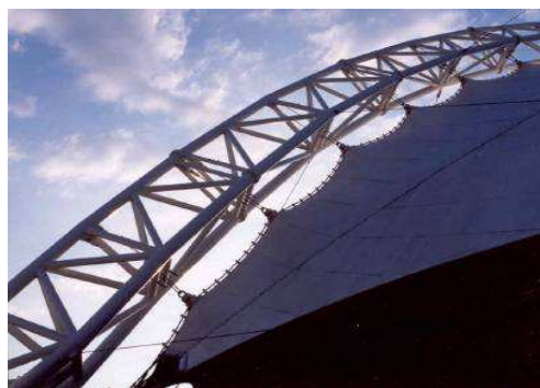
1. ábra: Egy rácsos ívre hagyományos módon, rövid, független kábelekkel feszített ponyvaszerkezet (Bank of Amerika Pavilion, Boston, MA, USA)
