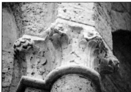
34. kép: Ócsa, a déli mellékkápolna-külső északkeleti fejezete
