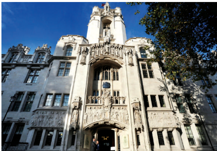
35. Az Egyesült Királyság Legfelsőbb Bíróságának helyt adó épület homlokzata
