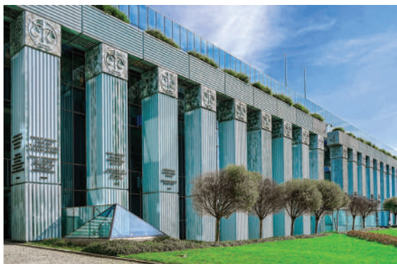
23. A bírósági épület egyik kolonnászerű oszlopsora...
