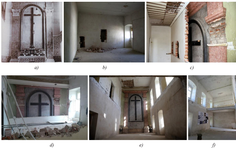
27. ábra. Malacka, a kastélykápolna a) archív képe, b)–d) feltárásának állapotfotói, e)–f) a kápolna belső terének helyreállított egysége
