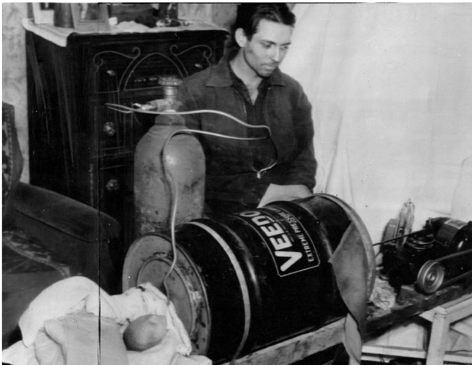
4. ábra Olajos hordóból és porszívómotorból eskábált lélegeztetőgép
