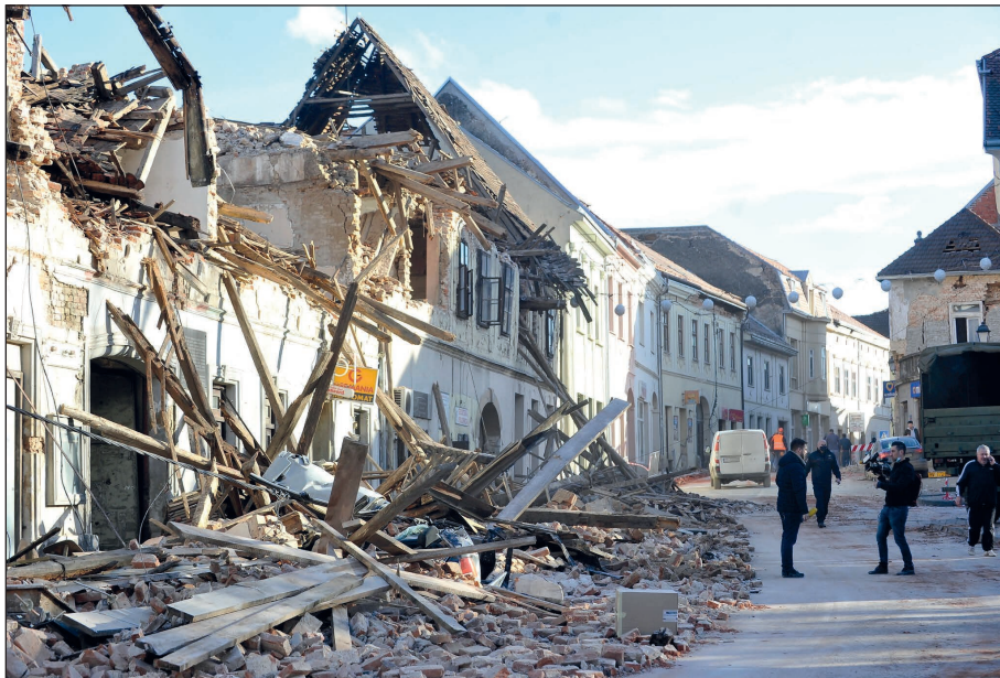
5. ábra. A petrinjai földrengés pusztítása (Forrás: [2] AP)
