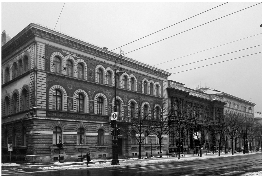
5. kép: Az egykori Mintarajztanoda, a Régi Múcsarnok és a Régi Zeneakadémia tömbje a budapesti Andrásy úton
