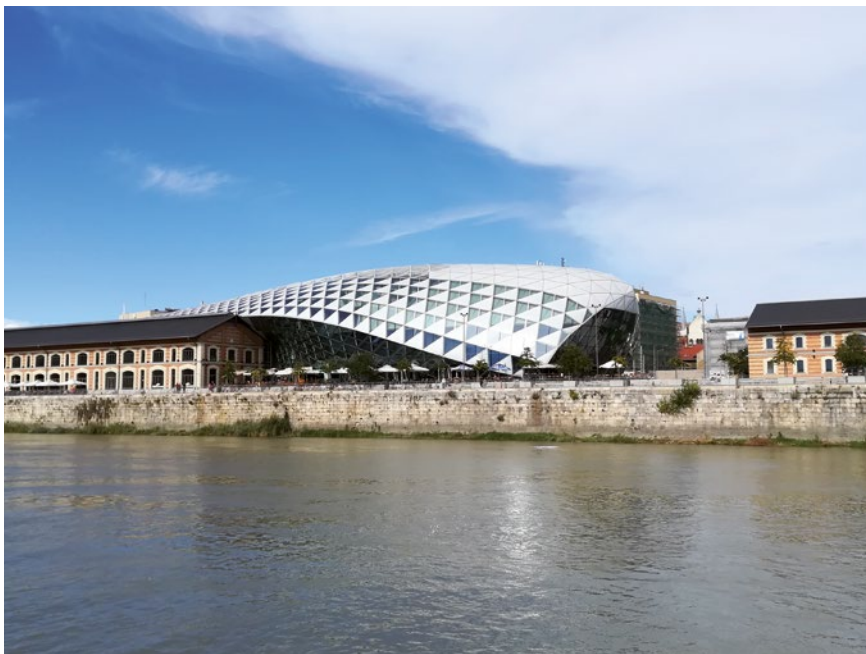
7. fotó A Közraktárak felújított és modernizált épületei – a Bálna
