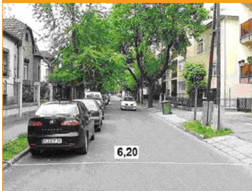
2. ábra: A 6 m körüli útszélesség problémái
