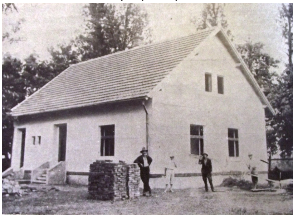
13. kép Telepes ház építése
