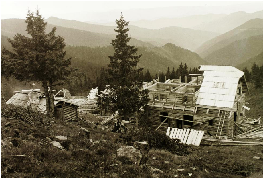
12. kép Menedékház épül a Pop Iván csúcs alatt
