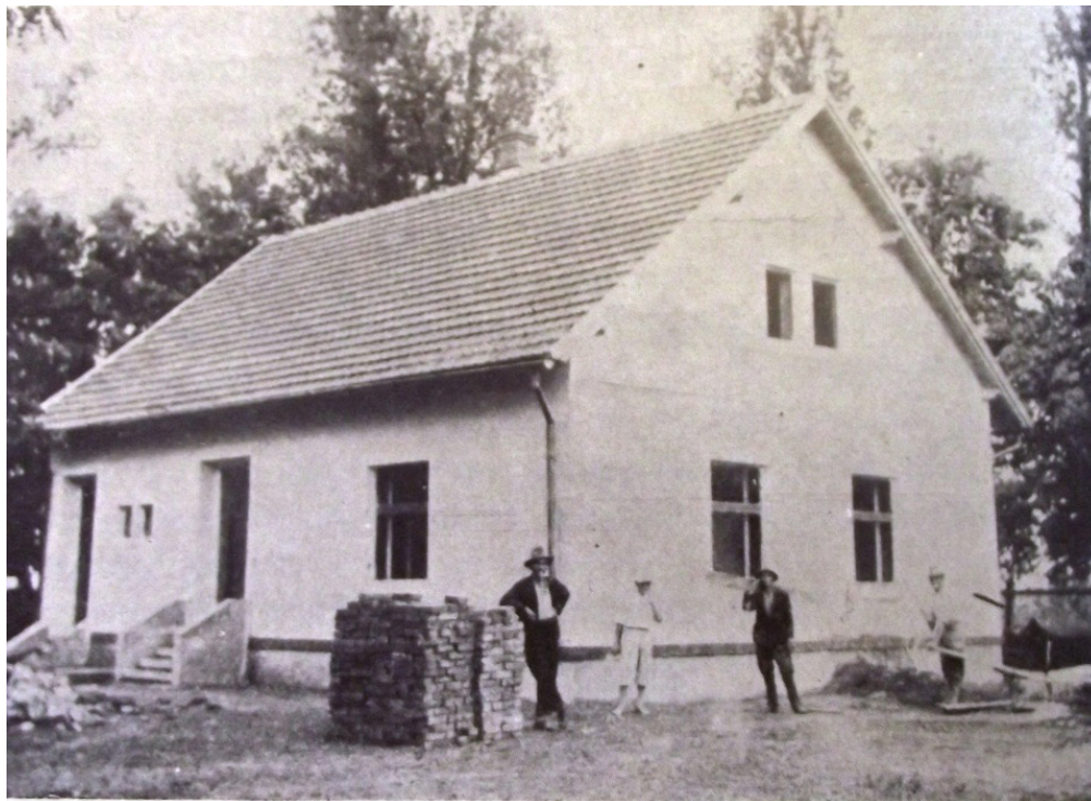
13. kép Telepes ház építése
