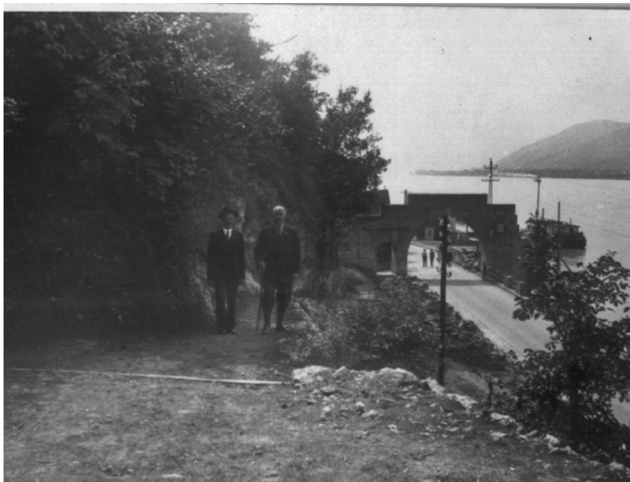
10. kép Zsitvay Tibor a turistaút építésénél, 1938.szeptember 11.
