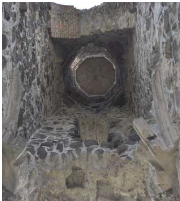
7. A templom toronyalja az in situ boltvállakkal
