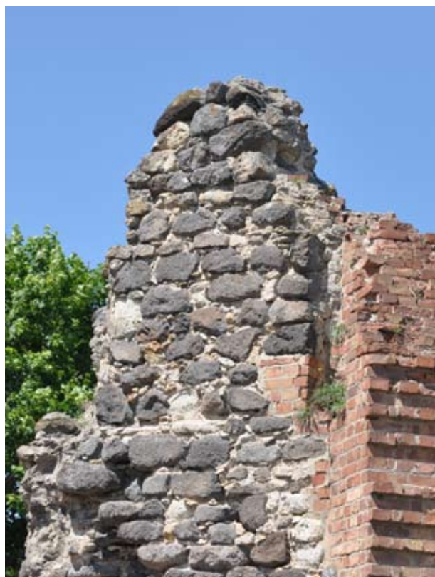
2. A bordás boltozat vállainak és homlokíveinek fennmaradt fészkei a templom szentélypoligonjának ÉK-i falán
