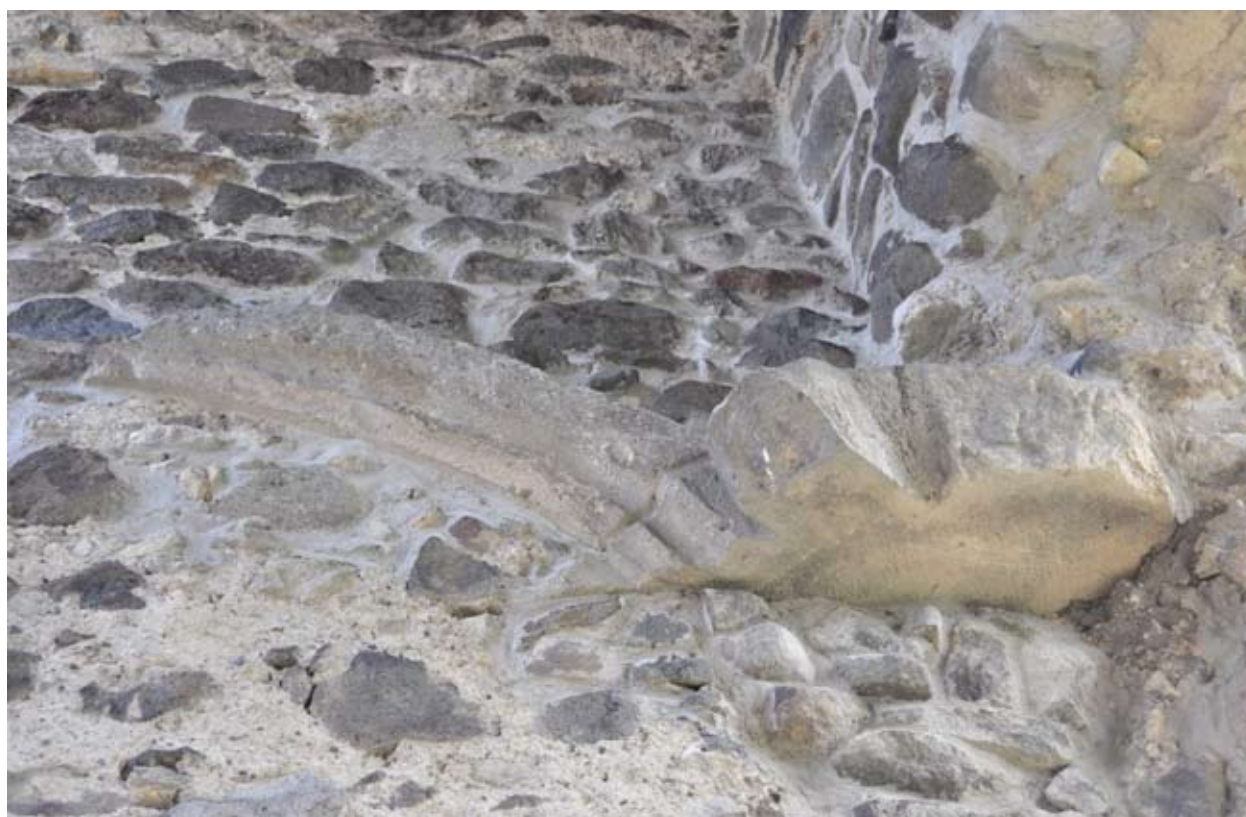
6. A toronyalj in situ boltválla és homlokíve a DK-i sarokban
