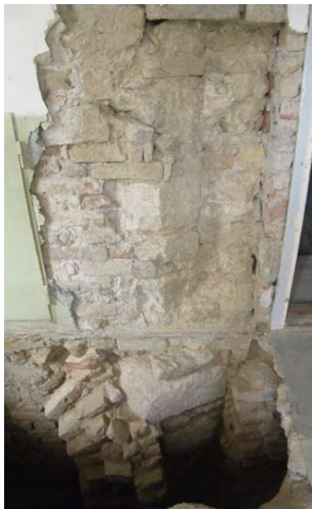
18. A III. támpillér délről, beépítve a folyosó északi falába
