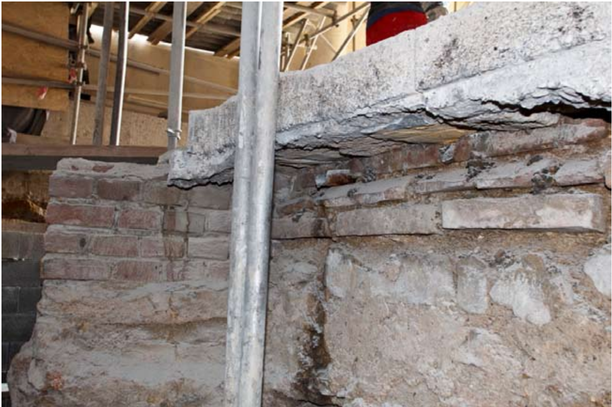
Az északi apszis kívülről a védőépület északi oldalának elbontása után
