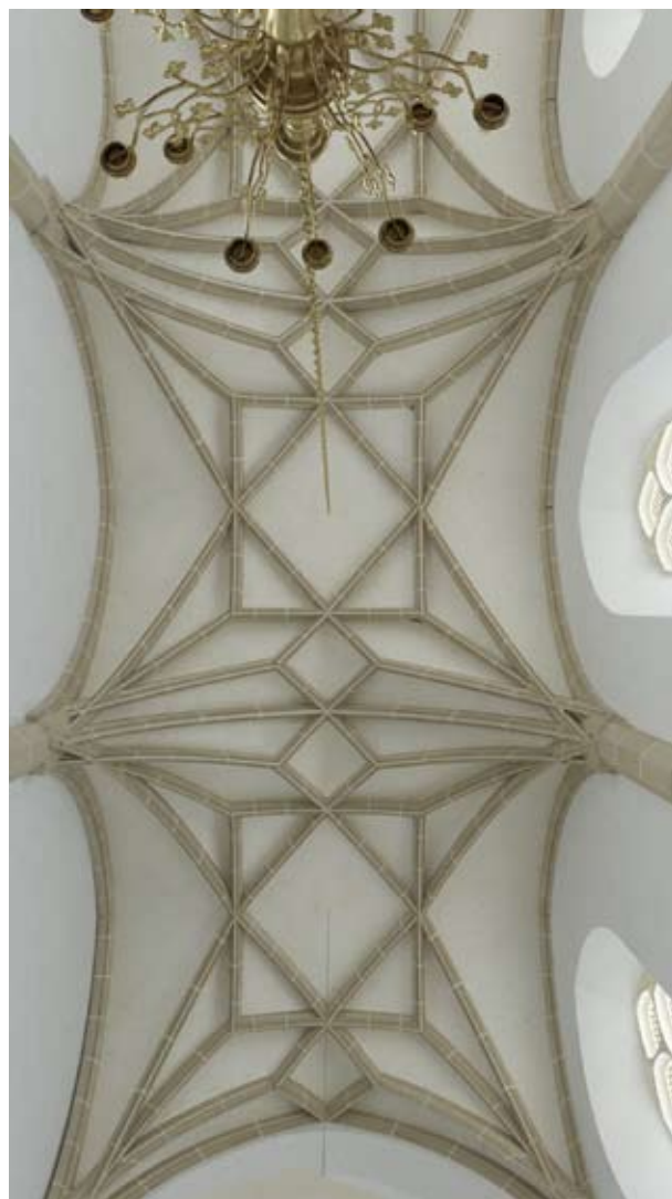
A szekszárdi apátsági templom későgótikus boltozatának rekonstrukciója (Buzás Gergely rekonstrukciója nyomán, Pazirik Informatikai Kft.)
