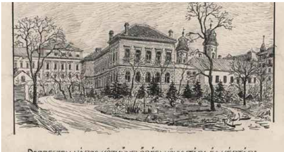
3. ábra. A Kollégiumi Fűvészkertben felépített új iskola, (később: elemi- és polgári fiúiskola, 1948-ban államosították, benne általános iskola működött, majd 1989-ben a Tiszántúli Református Egyházkerület kapta vissza az épületet.
