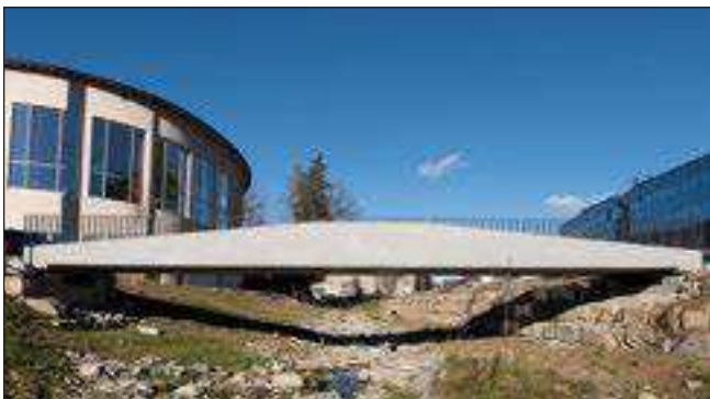
4. ábra: A világ első, csak karbonbetonból készült hídja Albstadt-Ebingenben (Solidian)
