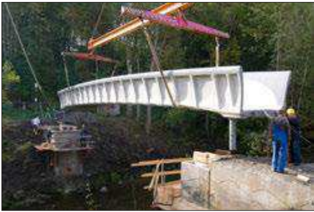
2. ábra: Karbonbeton gyalogos és kerékpáros híd beépítése Kemptenben (TU Dresden)
