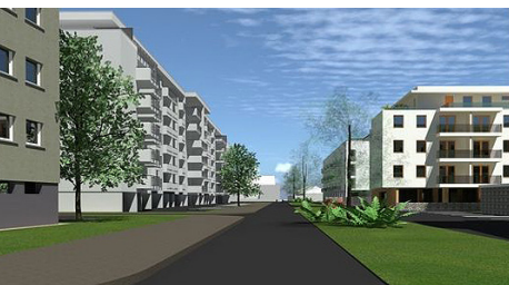
[...] a jövőre felépülő társasházak [...] [a tervezők említése nélkül]
