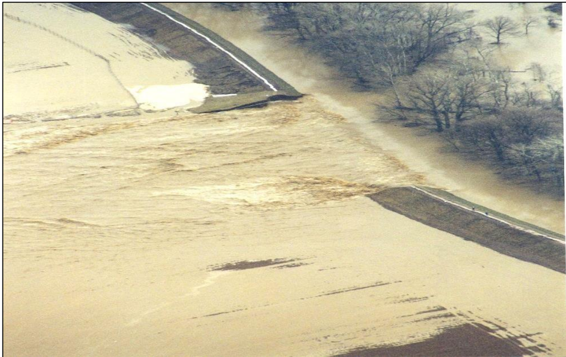
2. sz. kép: Tarpai gátszakadás 2001-ben
