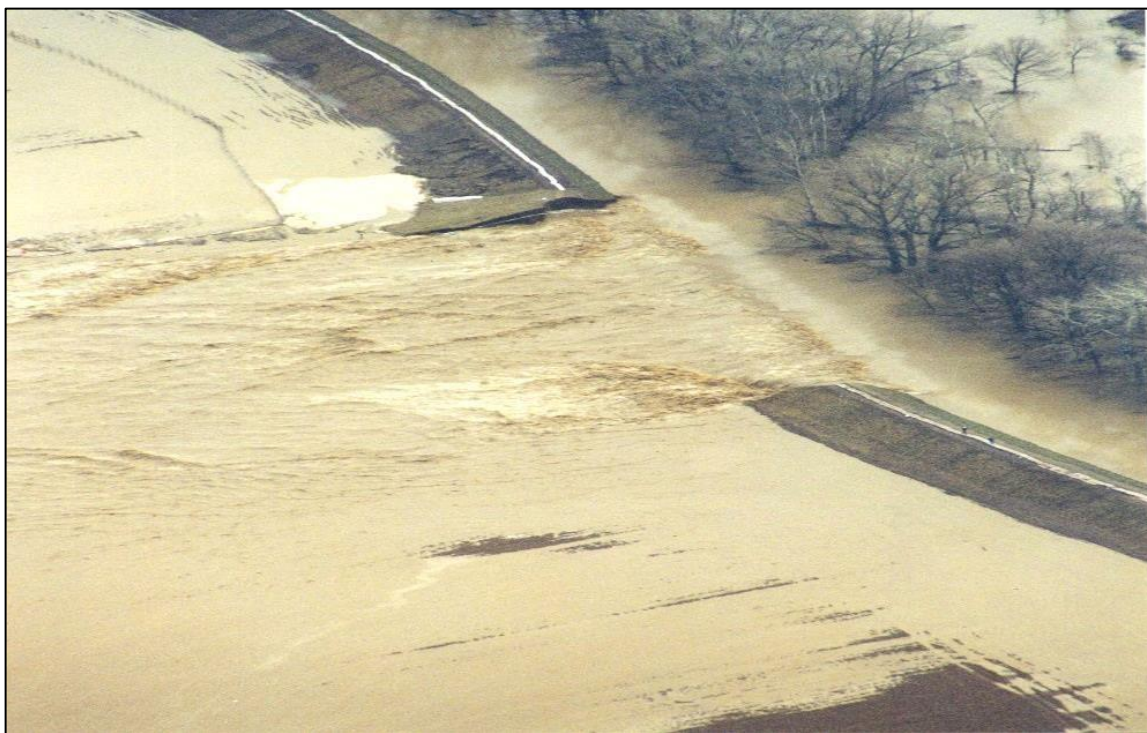
2. sz. kép: Tarpai gátszakadás 2001-ben
