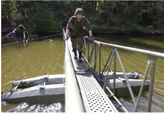
8. sz. kép Az úszó aljzat beépítve 19
