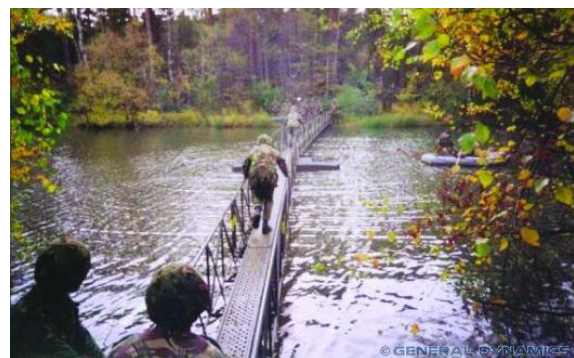
11. sz. kép Átkelés az úszó aljzatú hídon 23
