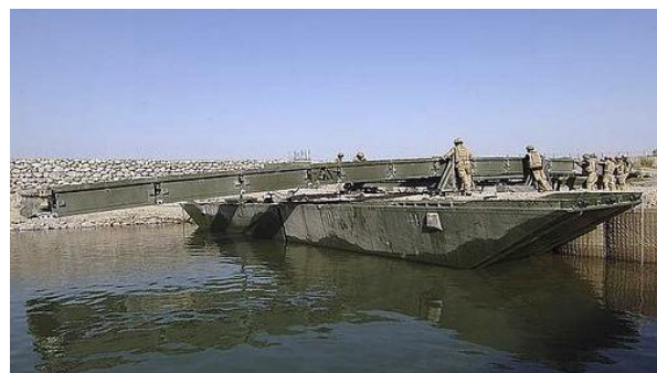
35. sz. kép A komp építése 62
