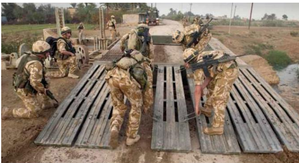
32. sz. kép Rombolt híd javítása „ráépítéssel” az Eufrátesz mellékfolyóján 58
