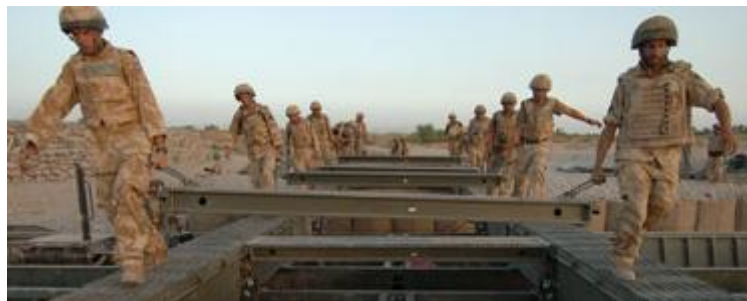
16. sz. kép A híd járófelületének beépítése 41
