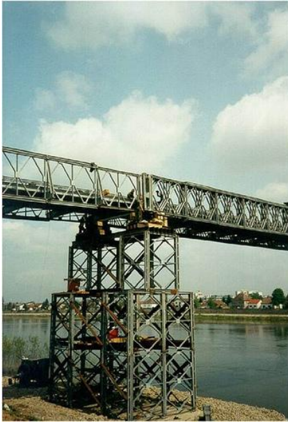
31. sz. kép A híd fix alátámasztása 56
