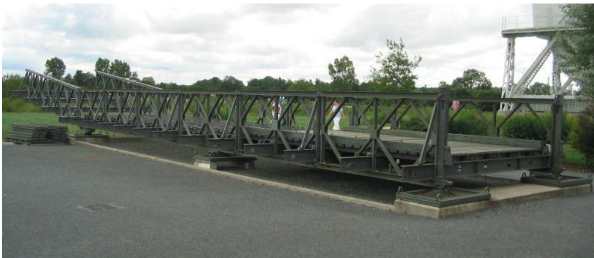
2. sz. kép A Bailey híd 11
