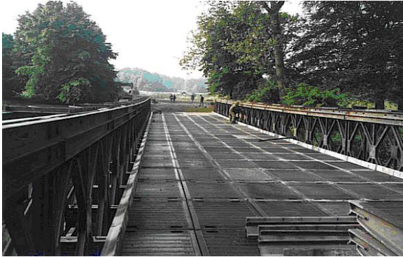
14. sz. kép Nehéz Gerengatartós Híd építése 29
