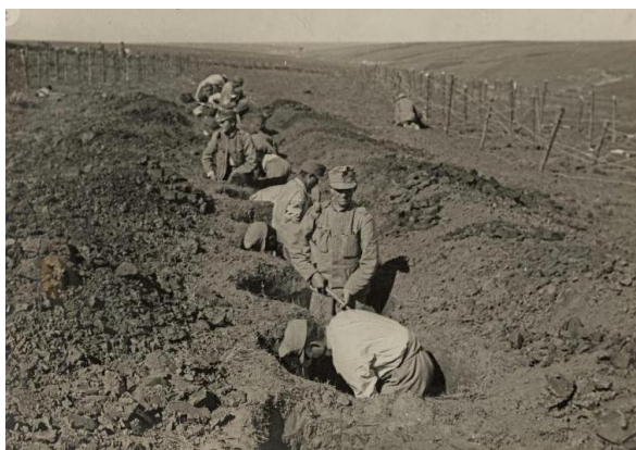
Farkasverem készítése és az állások előtt elhelyezkedő csapdák [43], [44]
