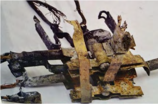
2. ábra. Kontaktkorrózió okozta károsodás villamos kötésnél
