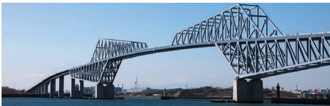
4. ábra: Tokyo Gate híd – BHS500 és BHS700 nagy szilárdságú acél felhasználásával [6]
